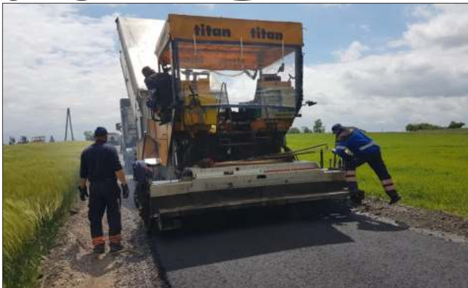
Prace związane przebudową drogi w miejscowości Malankowo
