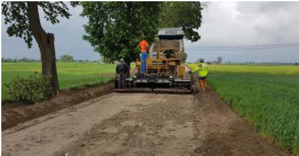
Prace modernizacyjne drogi Linowiec-Wierzbowo
