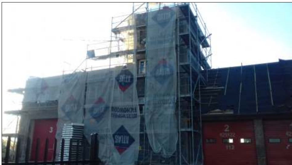
Aktualnie trwa ocieplanie budynku oraz wymiana poszycia dachowego
