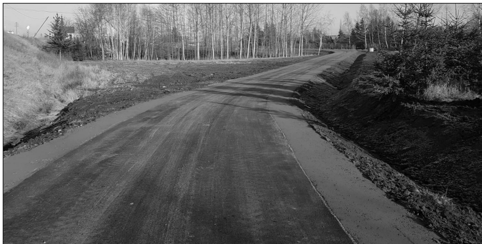
Nowa bezpieczna droga prowadząca do oddalonego o 250 m przejazdu przy drodze Malankowo - Pniewite
