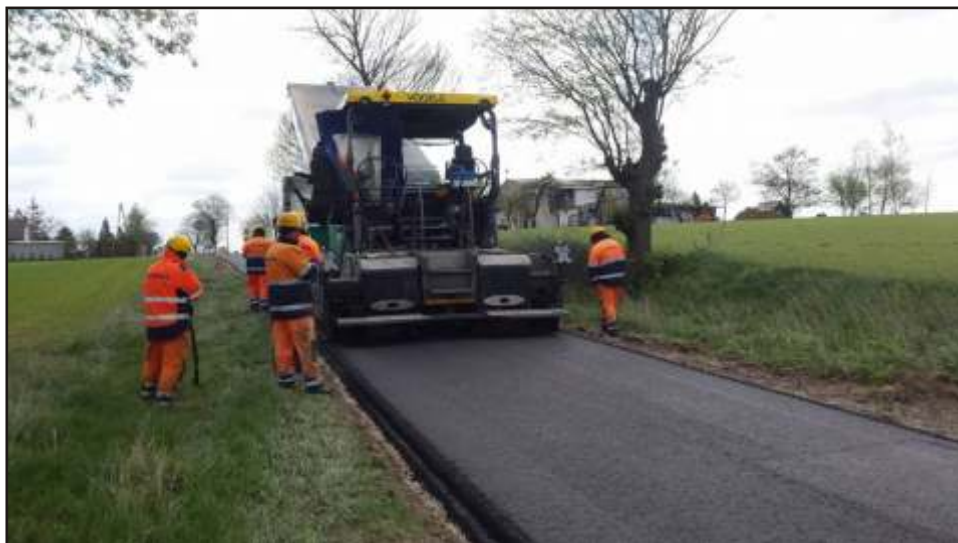
Prace związane z przebudową drogi w miejscowości Lipienek
