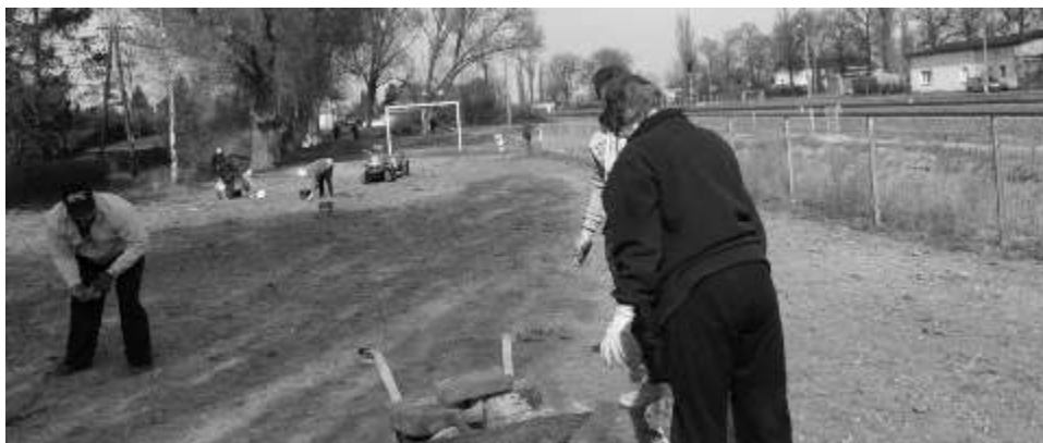
Prace mieszkańców przy budowie boiska w Kornatowie
