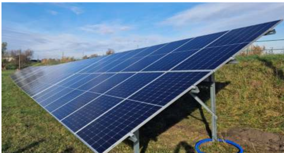
Instalacja paneli fotowoltaicznych na oczyszczalni ścieków w Lisewie
