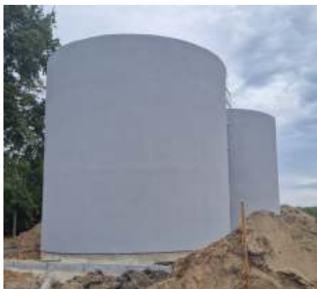
Rozbudowa sieci wodociągowej
