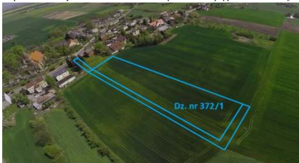
Teren przeznaczony pod budowę nowego osiedla w Lisewie
