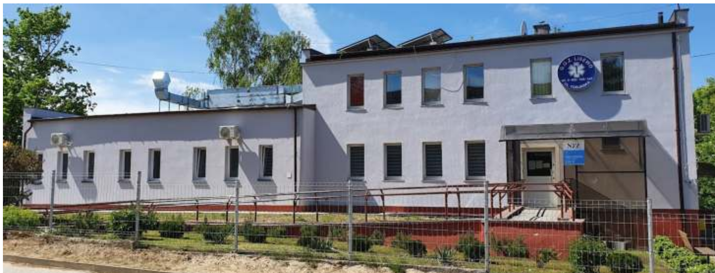
Budynek Gminnego Ośrodka Zdrowia w Lisewie
