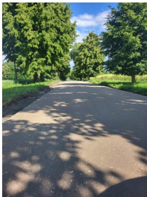
Przebudowana drogi w Lipienku
